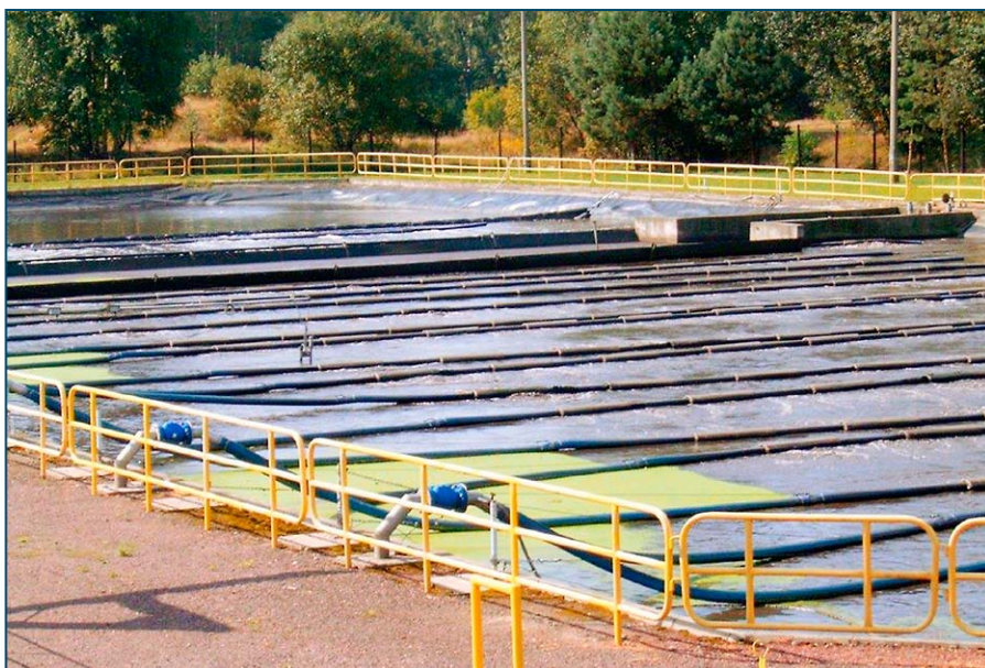
Fot. 2. Ciąg technologiczny Biolak
