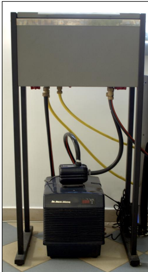
Ryc. 10. Instalacja regulująca temperaturę wody
