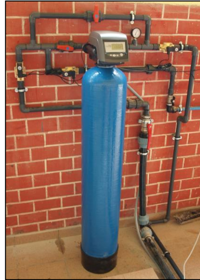
Ryc. 9. Filtr obniżający mętność na ujęciu powierzchniowym
