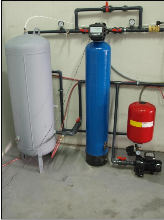
Ryc. 8. Odzłaziacz wraz z filtrem do obniżania mętności
